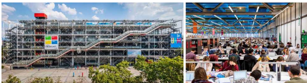
Рис. Б.6.2. Центр Жоржа Помпиду, 1977 р., Париж, Франція (архітектори: Ренцо Піано (Renzo Piano), Річард Роджерс (Richard Rogers)) [244]
