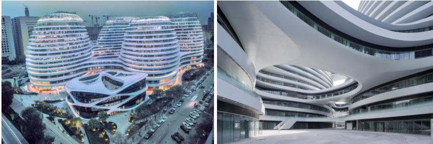
Рис. 1. Торговельно-розважальний комплекс Galaxy SOHO Mall (2008–2012 р.р., архітектор Заха Хадід)
